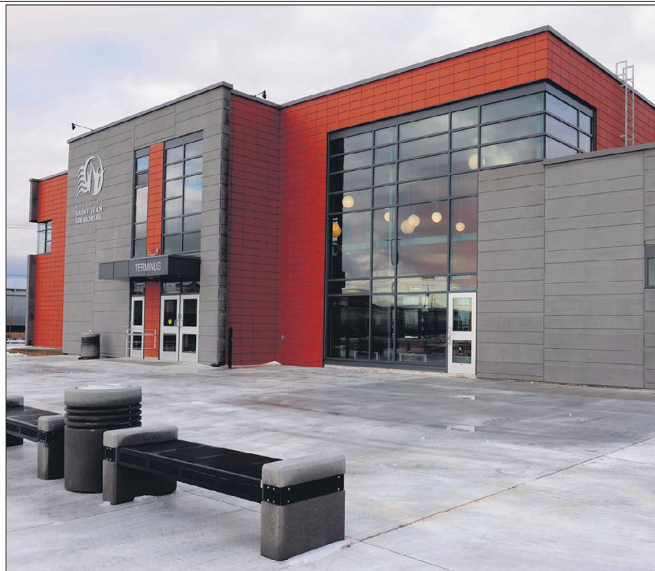
Le nouveau terminus a une fonction intermodale.
