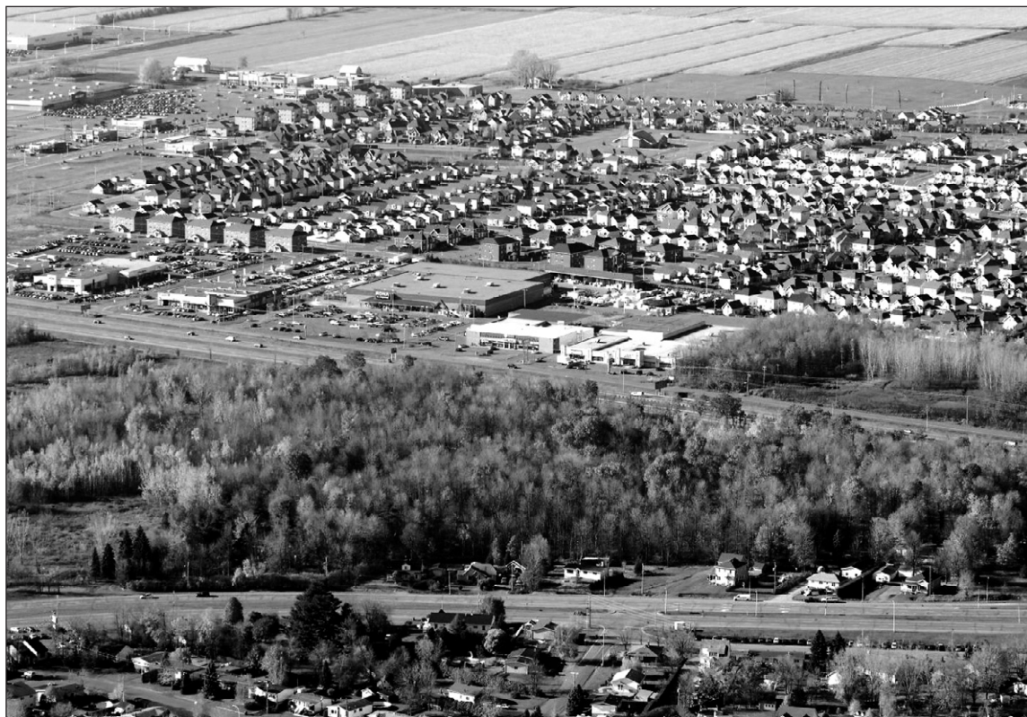
Le prolongement de la rue Douglas et l'aménagement d'un carrefour giratoire, à l'intersection de Douglas, du boulevard Saint-Luc et de la rue du Parc constitue le principal projet.
